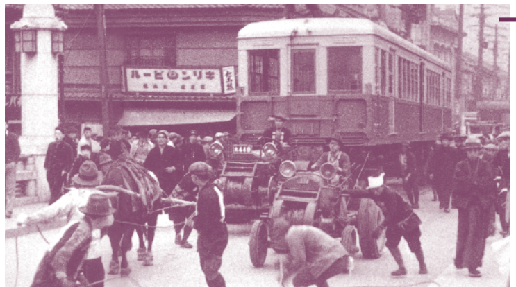
地下鉄完成間近、地下を走る車両の運搬は、車はもちろんな牛までも借りたして街中を運ぶ大がかりなものとなった
