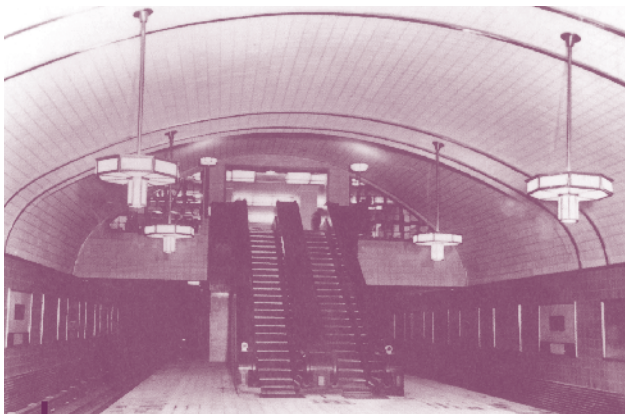
天井はアーチ型、シャンデリア様の照明やエスカレーターが備わるなど豪華で近代的な駅に人々は驚いた(地下鉄心斎橋駅)
